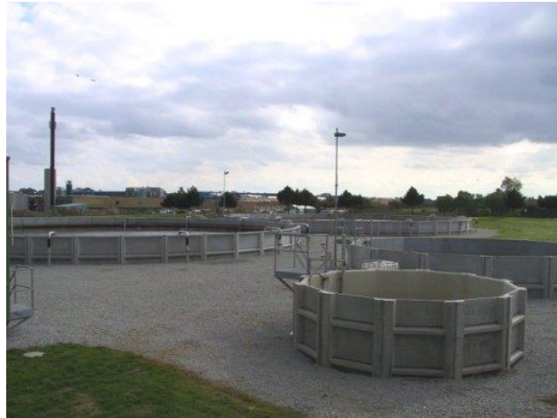
SBR tankene og de mindre slamtanke i forgrunden.
