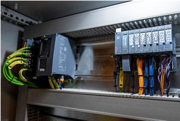
Komponenterne - incl. SIWAREX WP341 - der sammen er med til at styre produktionen.
